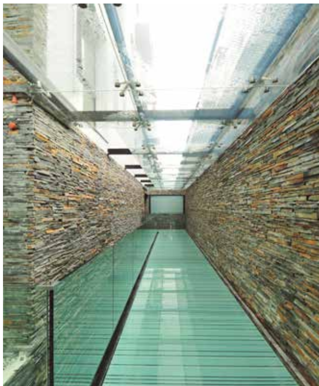
Lucernario Junta Departamental de Montevideo, cristal termopanel de control solar templado serigrafiado con puntos. Arq. Roberto Monteagudo – Oficina de Arquitectura de la Junta Deptal. de Mvdeo.
