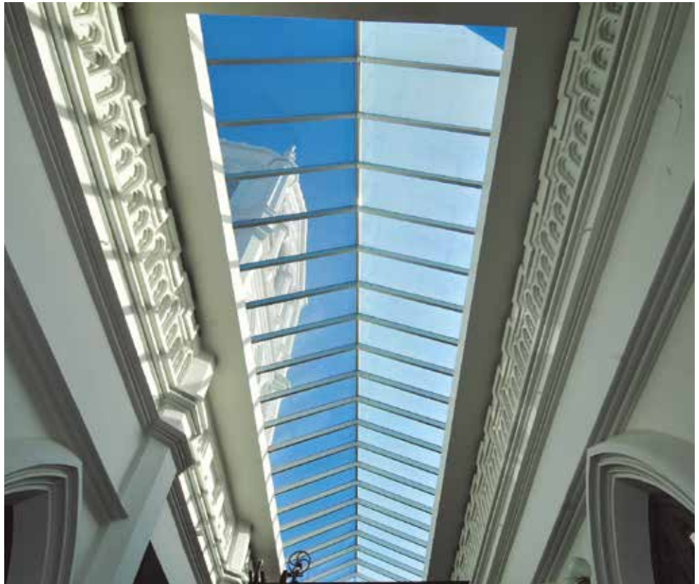
Lucernario Junta Departamental de Montevideo, cristal termopanel de control solar templado serigrafiado con puntos. Arq. Roberto Monteagudo – Oficina de Arquitectura de la Junta Deptal. de Mvdeo.
