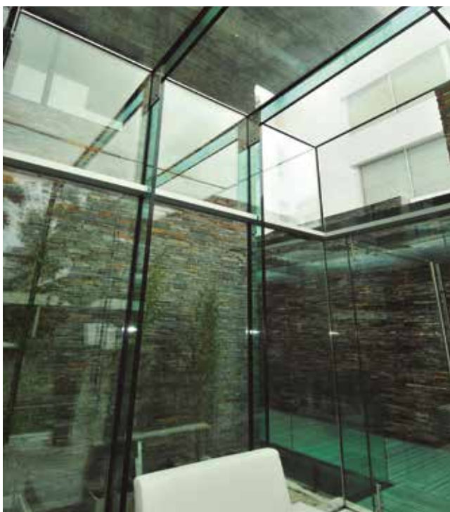
Lucernarios con vigas multilaminadas en cristal. Acceso al Edif. Le Bleu, Punta del Este. Arqs.Carlos Ott y Asoc.
