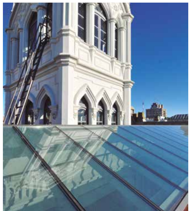
Lucernario Junta Departamental de Montevideo, cristal termopanel de control solar templado serigrafiado con puntos. Arq. Roberto Monteagudo – Oficina de Arquitectura de la Junta Deptal. de Mvdeo.
