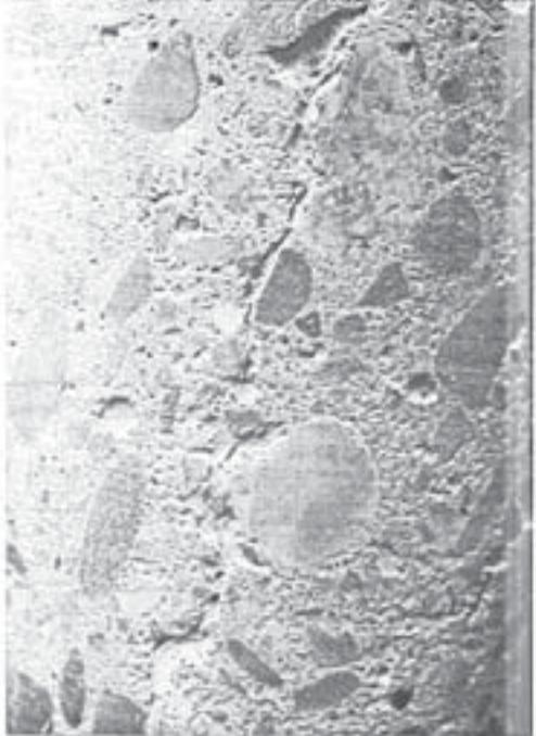
Figura 3 (Tamaño real de la fisura).
