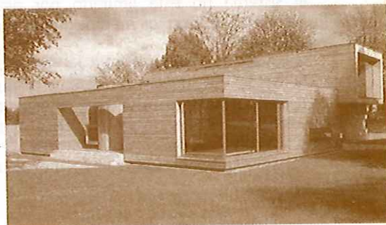
Abajo, guardería en Ludwigsburg. Obra de Bernd Zimmermann, (2000), ejemplo de la transformación del concepto de construcción en madera que suponen los nuevos sistemas superficiales. La madera se apropia de la cualidad tectónica del hormigón.
