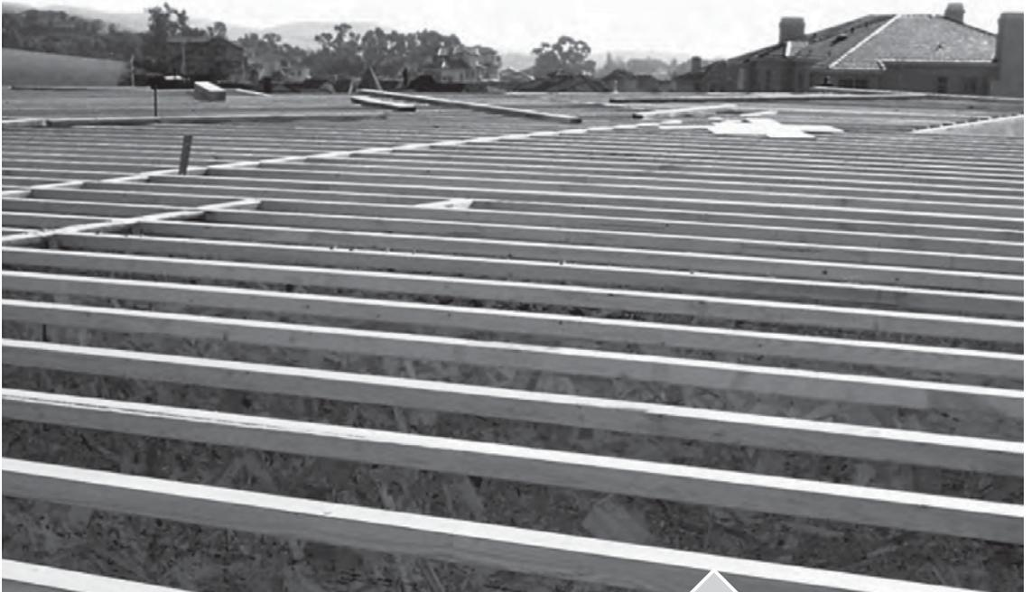
Armado de estructura de viga I con alma de **OSB** para pisos
