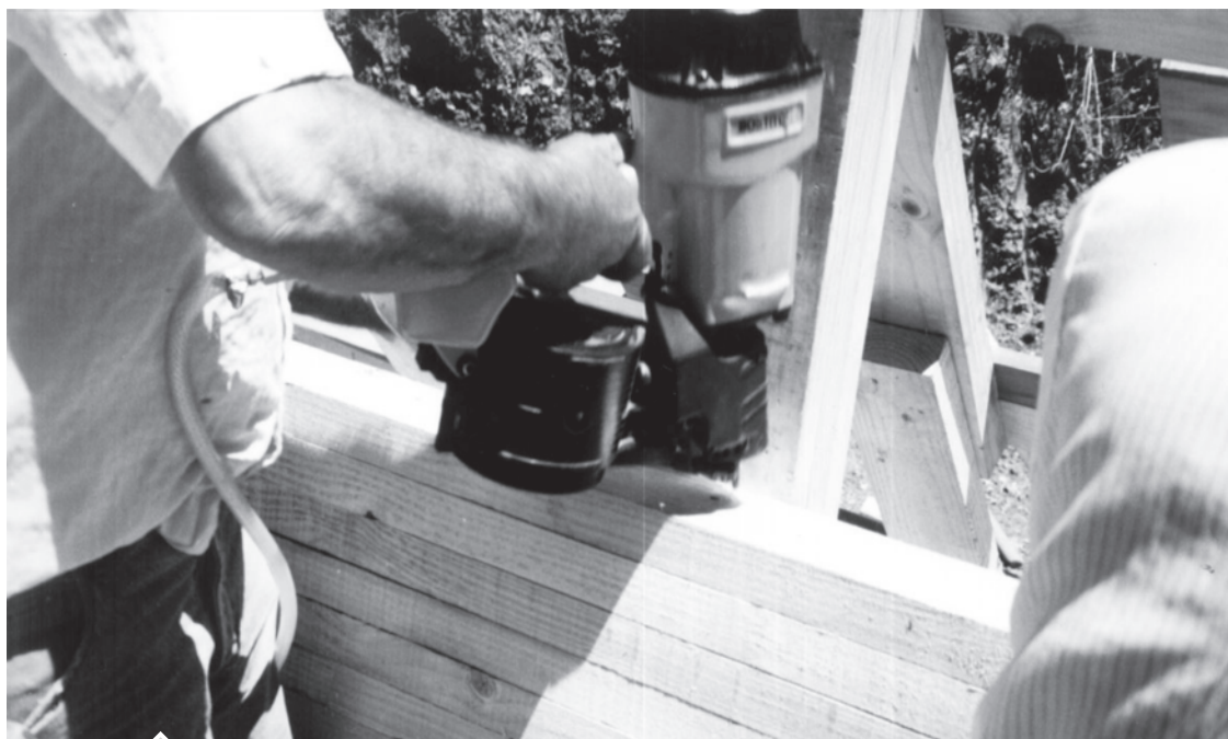
Placas de escuadrías de maderas clavadas
