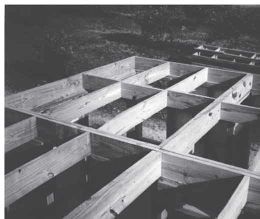
Paneles de entrepiso
