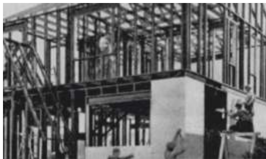
Prototipo para residencia en Steel Framing presentado en la Exposición Mundial de Chicago en 1933
