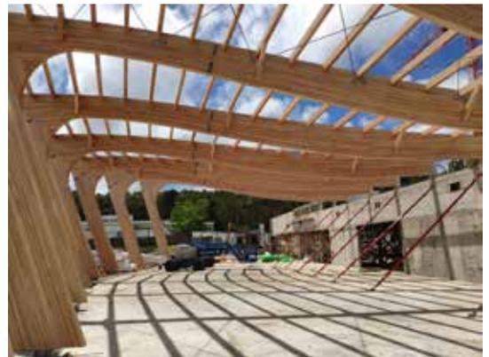
Figura 7. Montaje de los pórticos, colocación de las correas, sistema de arriostramiento, juntas de montaje con barras encoladas en las vigas y vista de pórticos y correas desde el exterior y el interior
