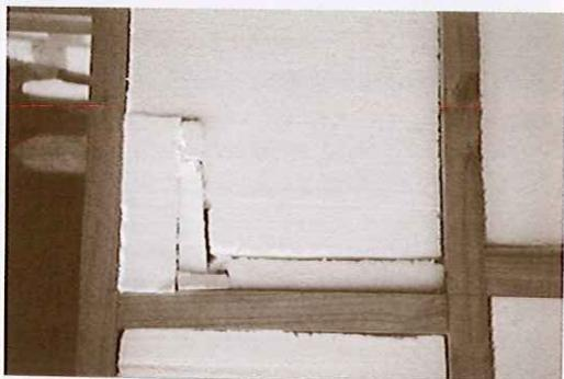
Foto 8. Evitar recortes en el aislante térmico
