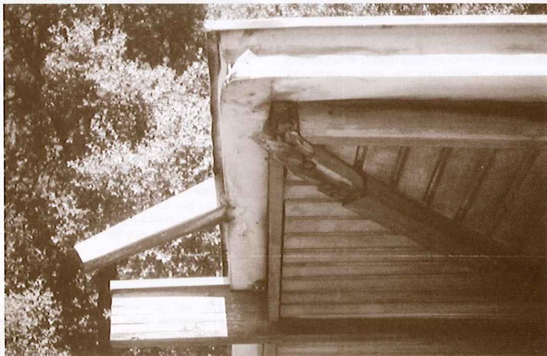
Foto 11.- Alero deteriorado por pérdidas en el canalón
