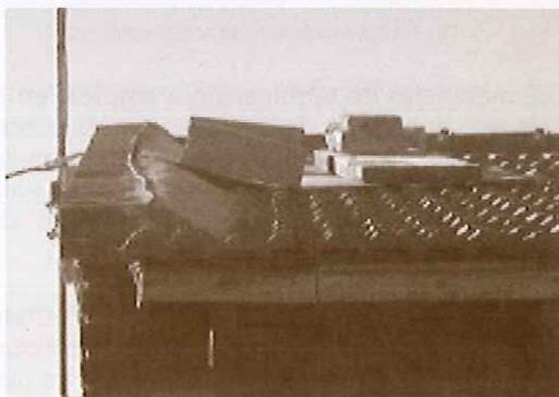
Foto 5 y 6 Resolución inadecuada de encuentro con muro
