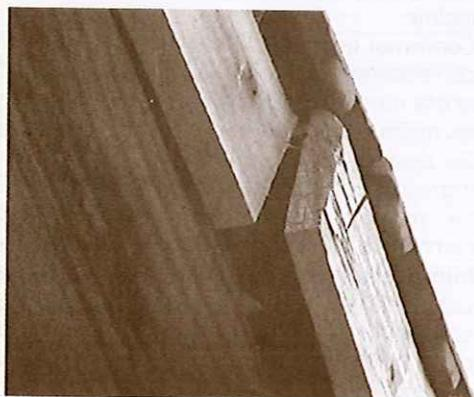
Foto 7 Cubretirante desclavado. Facilita el ingreso de agua a la estructura de madera
