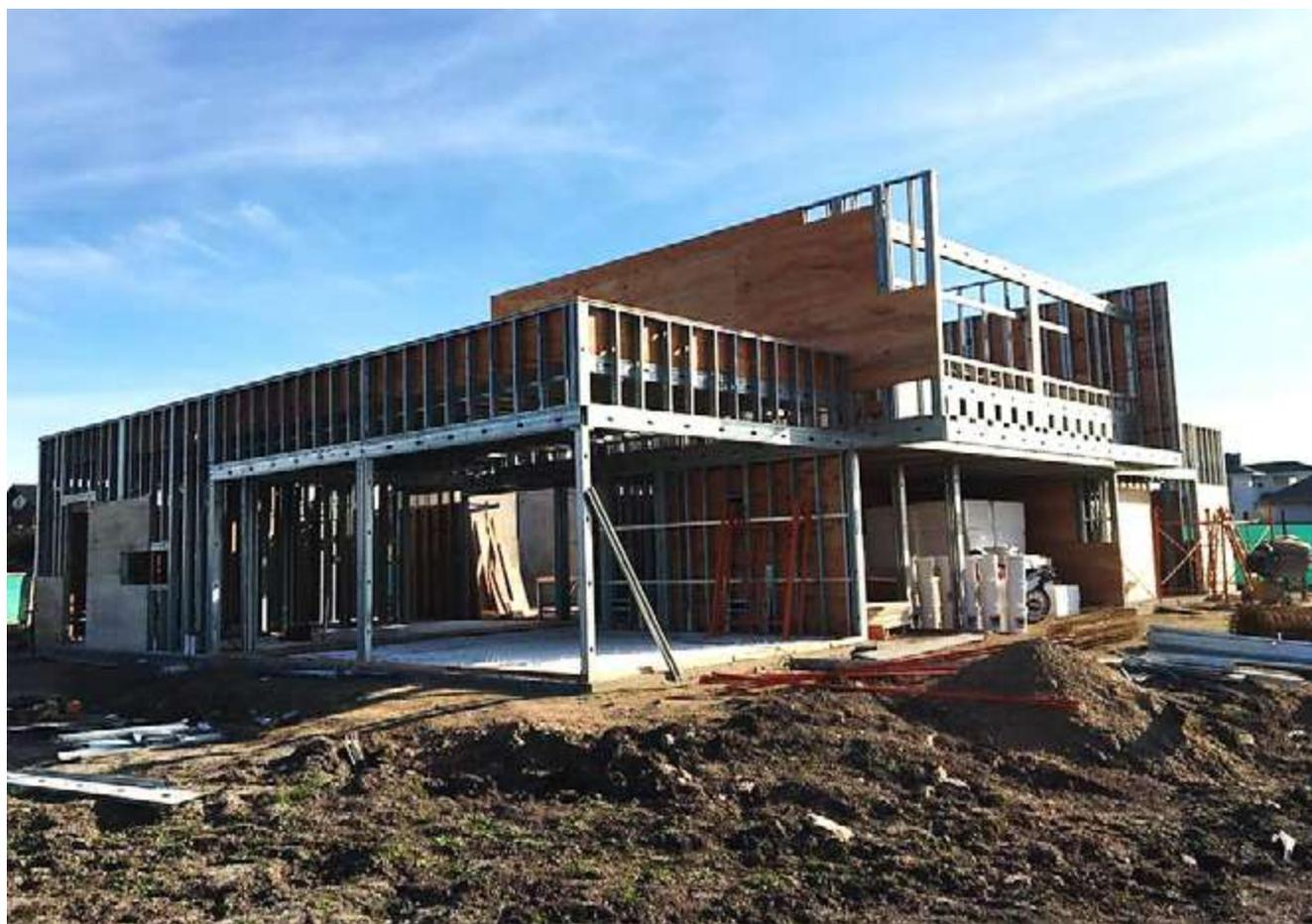
el armado completo de la estructura de Steel Frame. Permite acceder a las longitudes óptimas de suministro, minimizando cortes y desperdicios.
