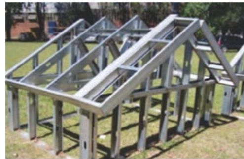
Fig. 2 - Panel en voladizo fijado al tímpano
