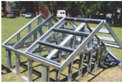
Fig. 1 - Panel pasante sobre el tímpano
