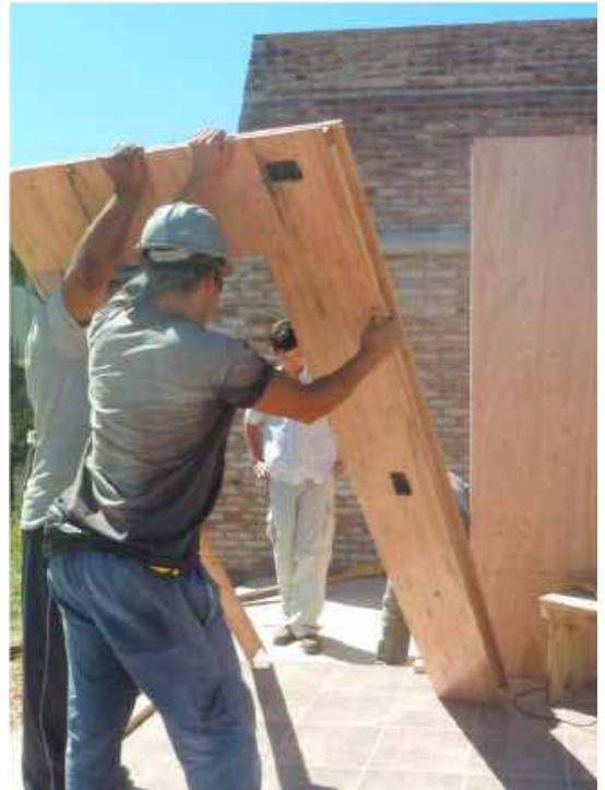
El sistema de machihembrado lateral entre paneles y encastre inferior a la solera, facilita y agiliza el montaje evitando apuntalados provisionarios.
