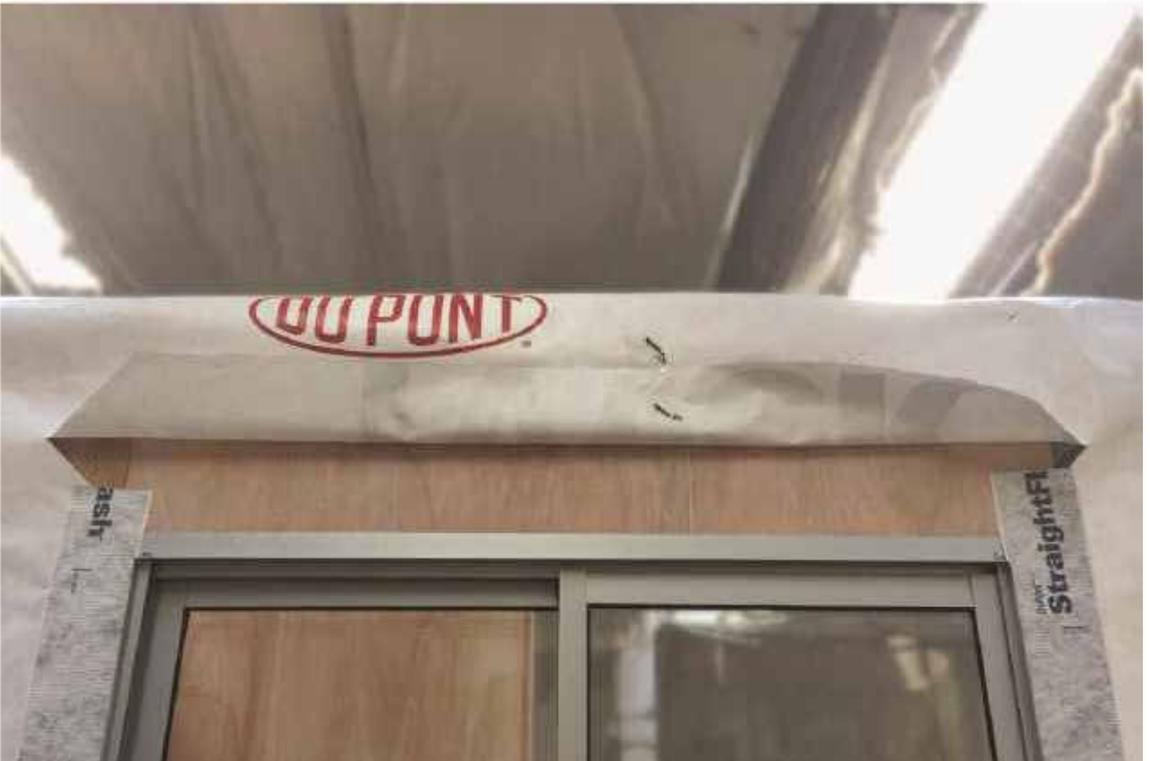
Posicionado y fijación con tornillo flangeados 4.2x25mm: nivelación, aplomado y escuadra.
