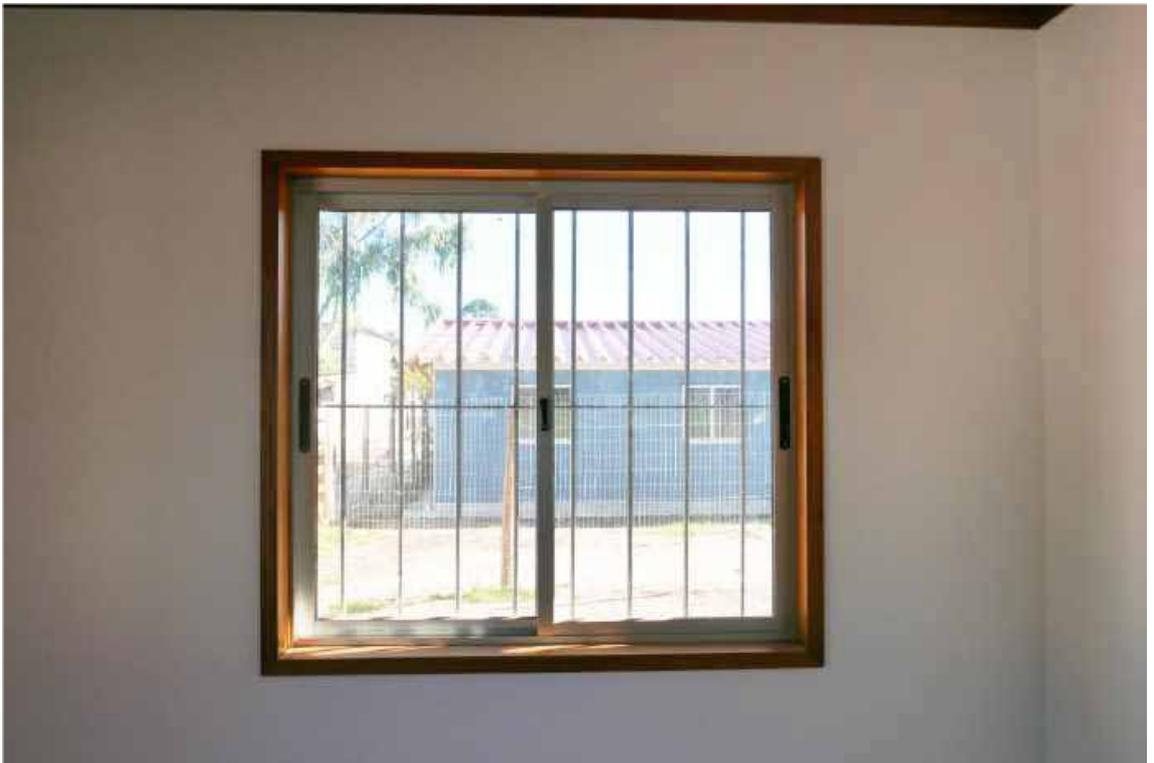
Las ventanas se terminan interiormente con una chambrana o forro de mocheta de madera en forma de L de 36,5 x 75mm de espesor, pintados con protector para madera y se colocan mediante clavos sin cabeza.
